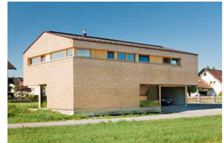
▲ Das Haus gewinnt durch sein niedrig gesetztes Dach einen kompakten Charakter. Die anspruchsvolle Planung lässt sich am Fensterband erkennen, das sechs Räume versorgt.
