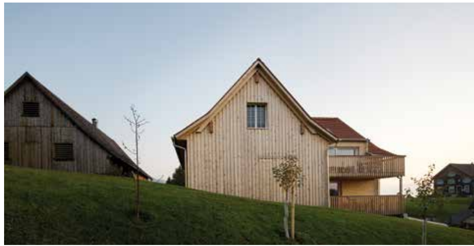
Das Gebäude war eigentlich marode und abbruchreif, nur die äussere Erscheinung stellte das Bundesdenkmalamt unter Schutz. Somit hatte der Architekt im Innern freie Hand, um neue Grundrisse zu schaffen.
