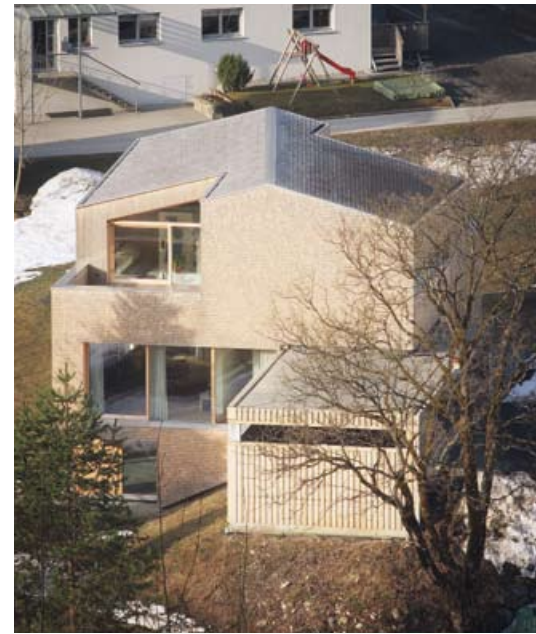
▲ Der schräge First sorgt im Obergeschoss für interessante Asymmetrien
