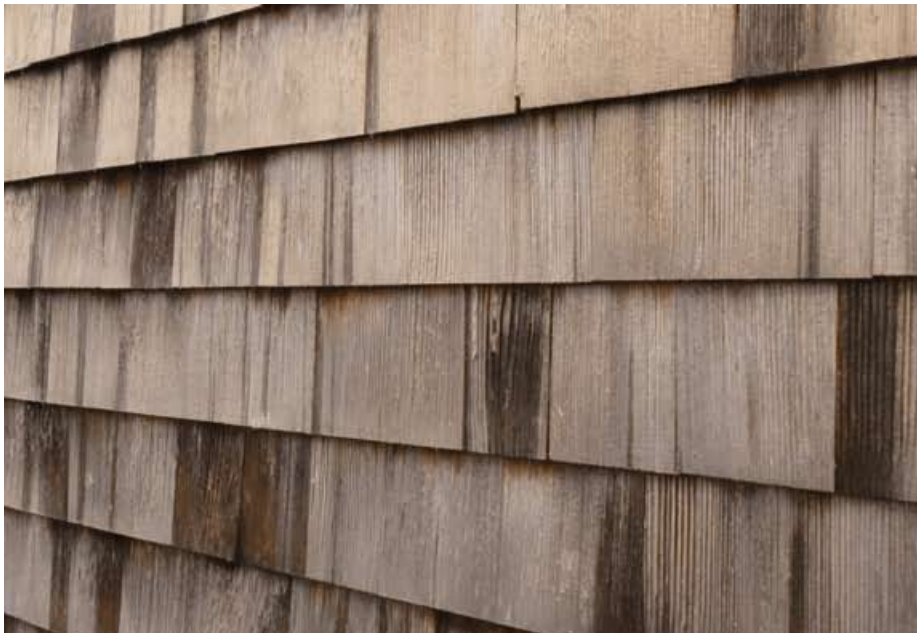
▲ Natürliche Patinierung: Die Fassadenschindeln aus heimischer Weißtanne sind mittlerweile vergraut, was der Bauherr als materialtypisch wahrnimmt und daher auch schätzt
