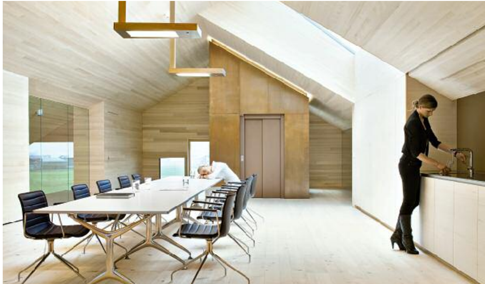
Der mit brüniertem Messingblech verkleidete Aufzugschacht gibt dem schmalen Galerieraum aus Holz eine elegante Anmutung. | The lift shaft clad with burnished brass sheet gives the narrow wooden room elegance.
