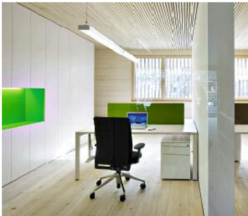
Die Lamellen dienen als Sicht- und Sonnenschutz. | The lamellas serve as visual covers and sun shields.
