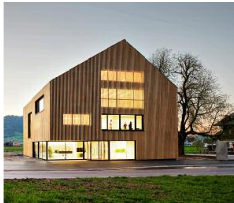
Abends werden die verborgenen Fenster sichtbar. | In the evening, the concealed windows become visible.
